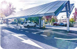
电动汽车充电站
